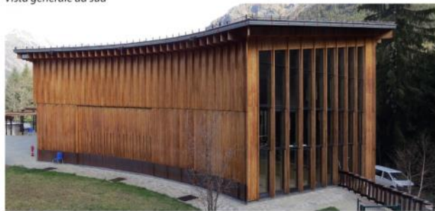
Il fronte sud
