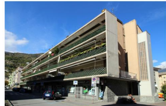
Vista generale da sud-est
