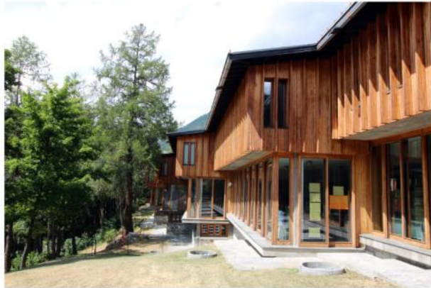
Particolare del fronte sud-ovest
